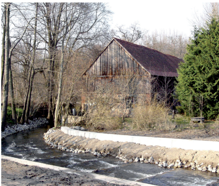
Abb. 32: Im Winter 2003/04 fertig gestellte Fischtrappe am Nonnenbach bei der Nonnenmühle im Landkreis Mecklenburg-Strelitz. In den vergangenen Jahren wurden im Nonnenbachtal zwischen der Wanzkaer Mühle und Nonnenmühle wiederholt Wasseramseln Cinclus cinclus beobachtet. Besonders bemerkenswert sind allerdings die hier am 10.07.1985 von Herrn U TESCH entdeckte Wasseramsel und der spätere Fang eines diesjährigen Vogels am 23.08.1985 durch H. RUTHENBERG. 01.04.2004. Foto: B. KLARE
